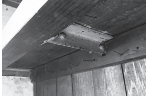
4131室 写真2-8 棚を支える山形鋼
