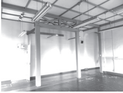
写真2-5 2本一組の木製の柱 4251室
