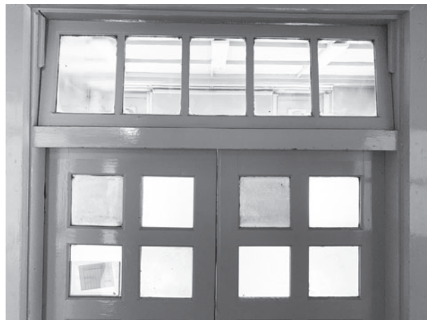
写真2-11 両開き扉のガラス(欄間左端が「銀線」) 4143室
