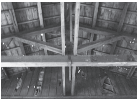
写真2-16 C館小屋組①
