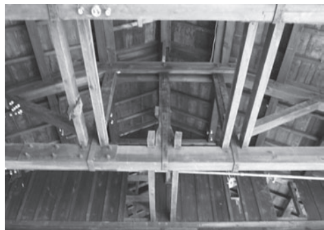
写真2-17 C館小屋組②
