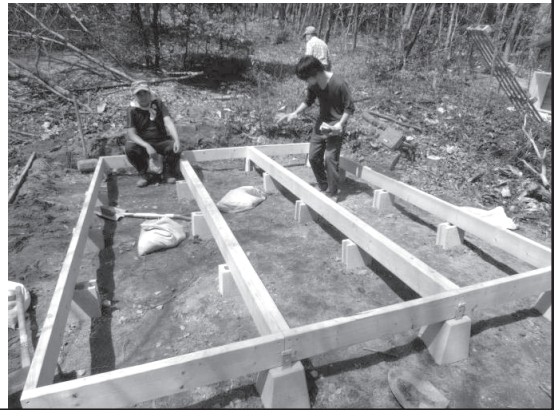
倉庫小屋の基礎作り
