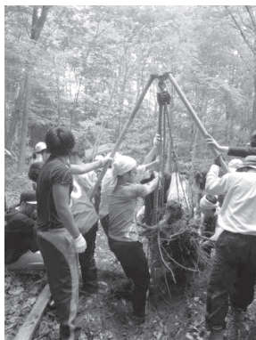
倉庫小屋作りのための整地、抜根作業
