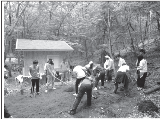
倉庫小屋建築予定地整地
