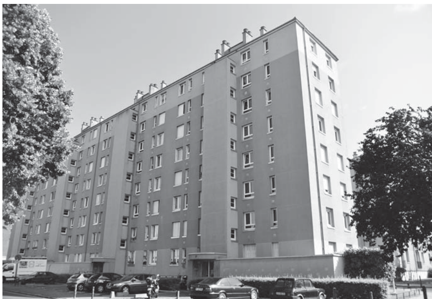
図15 第一〇次事業・集合住宅（八階建てである） 筆者撮影（2014年）
