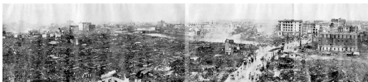
図1 京橋の第一相互ビルディング屋上より見た日本橋及神田方面の惨状(1923年9月15日) http://ja.wikipedia.org/wiki/ファイル:Desolution_of_Nihonbashi_and_Kanda_after_Kanto_Earthquake.jpg
